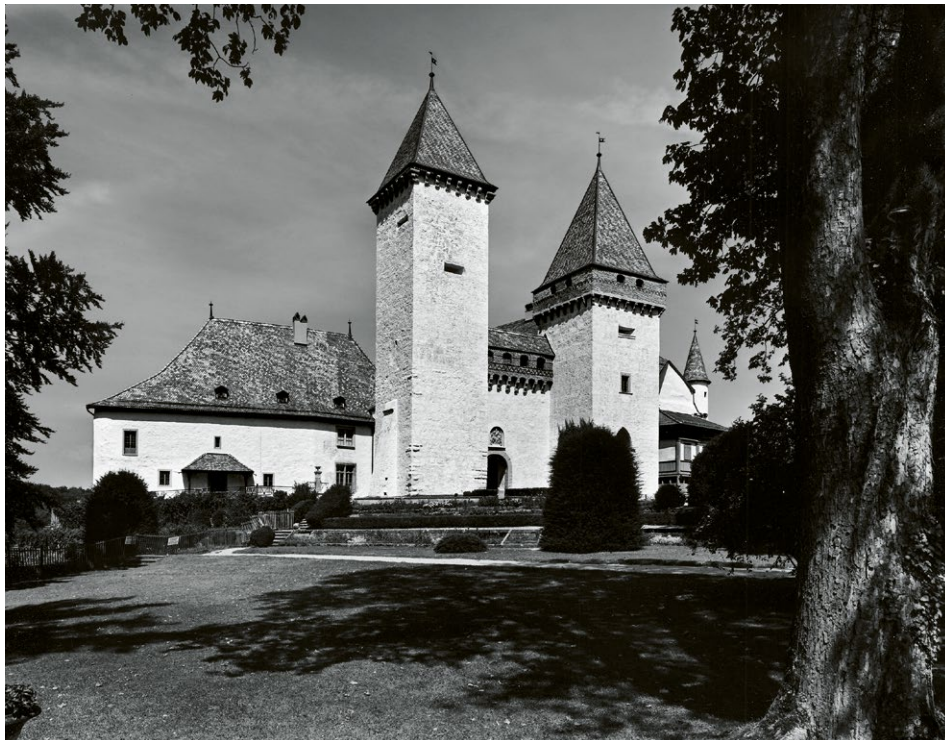
Ill. 12 Aile ouest et entrée principale flanquée des deux tours, la plus ancienne à gauche et celle de droite montrant un couronnement en briques, 1989.
