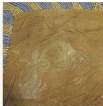
Taches de moisissure Détail du cat. 1
