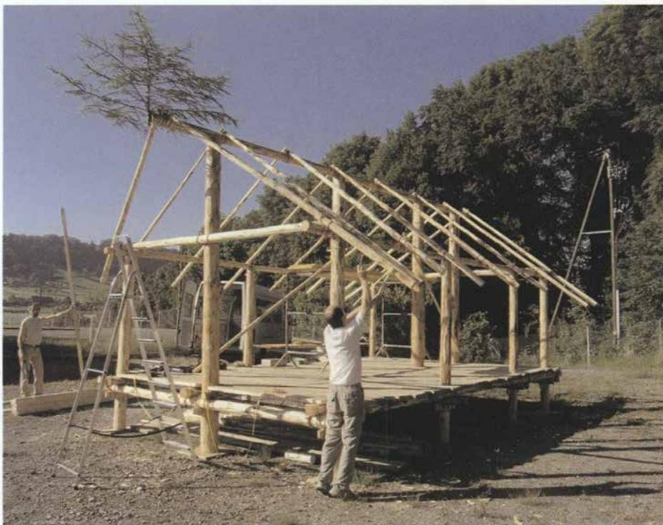
Fig. 56. La construction de la maison réalisée pour l'exposition, d'après le plan d'une maison de Concise datée de 2480 av. J.-C. (voir fig. 50).
